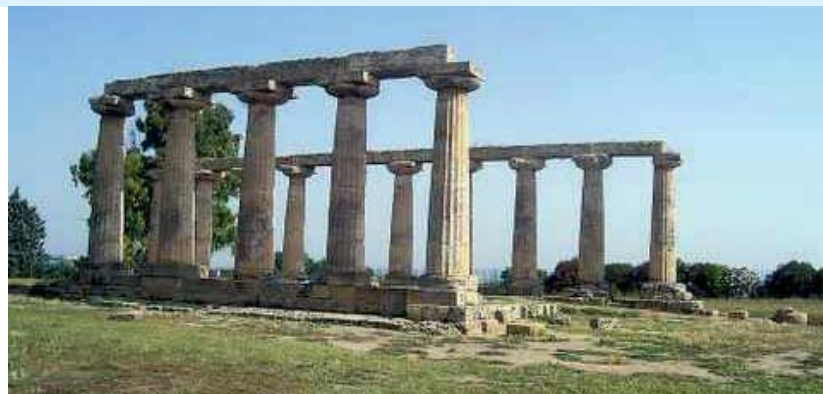
13. Tempio di Hera a Metaponto (VI secolo a. C.): già oltre 700 le tombe rinvenute nel cantiere
