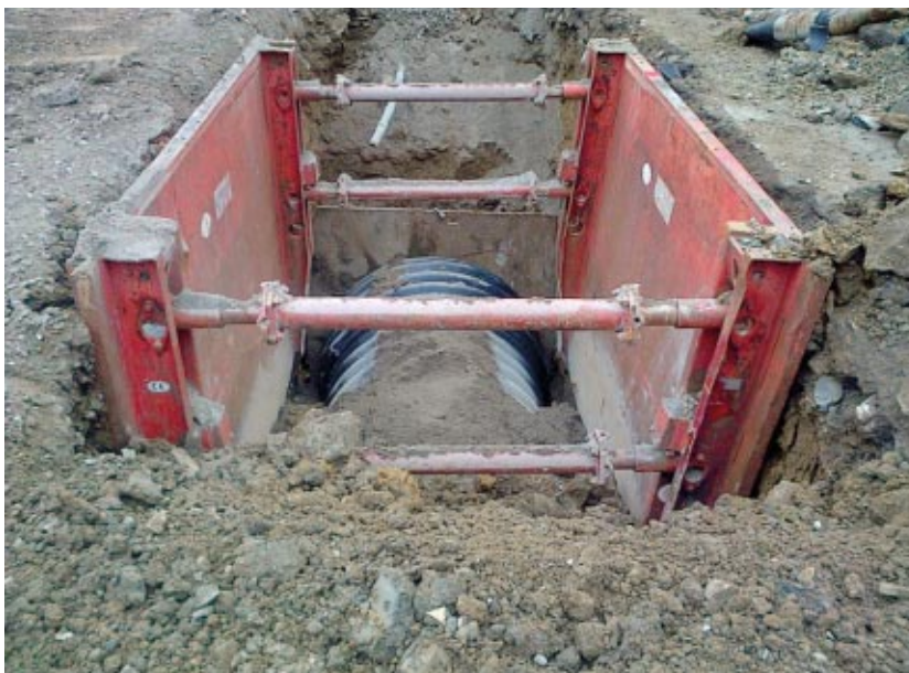
SISTEMA DI BLINDAGGIO CON CASSERI METALLICI ARMATI DURANTE LA POSA DELLA CONDotta
